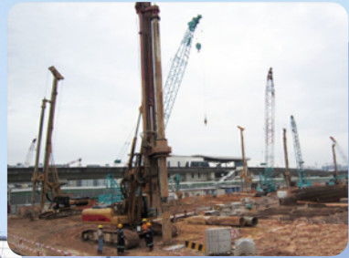
Changi Airport, SINGAPORE (FAR250) 新加坡, 樟宜机场 (FAR250)
